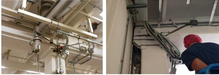
Fig. 20 - Legatura pilastro-trave: compatibilità con macchinari ed impianti.
