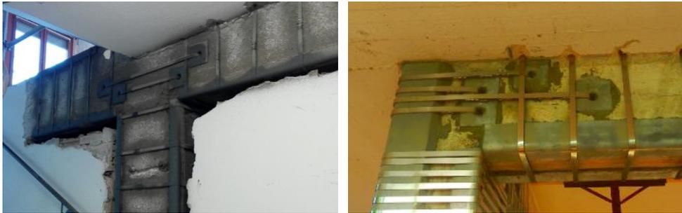
Fig. 18 - Interventi sui nodi trave-pilastro carenti di armatura
