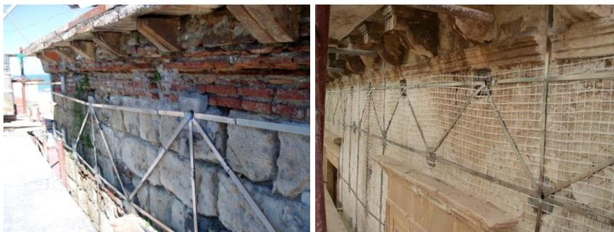
Fig. 8 - Realizzazione del cordolo CAM
