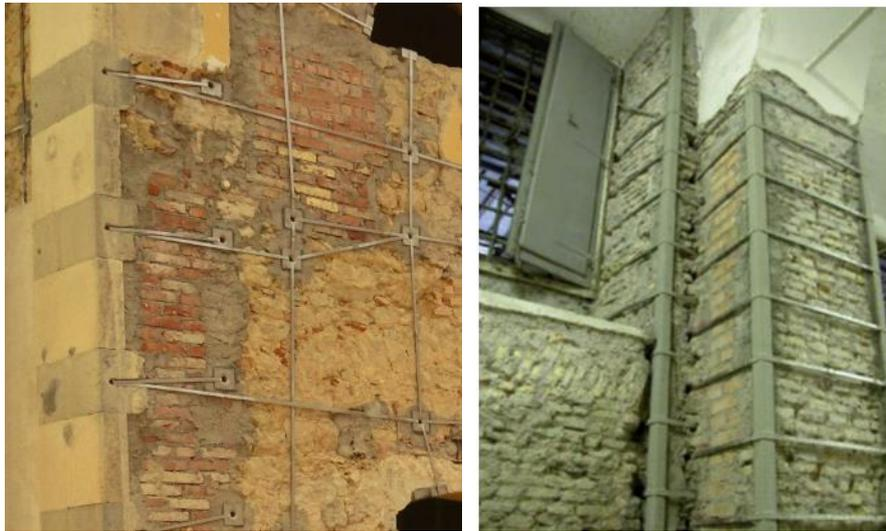
Fig. 7 - Ammorsature efficaci anche in presenza di cantonali in pietra a vista
