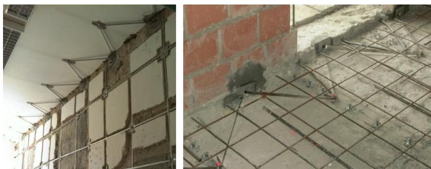
Fig. 9 - L'arpionatura dei travetti del solaio all'intradosso e all'estradosso
