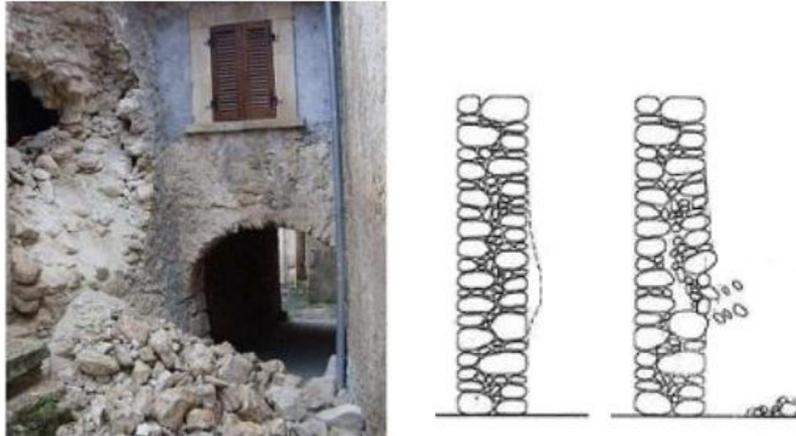
Fig. 5 - La rottura per disgregazione dell'apparecchio murario
