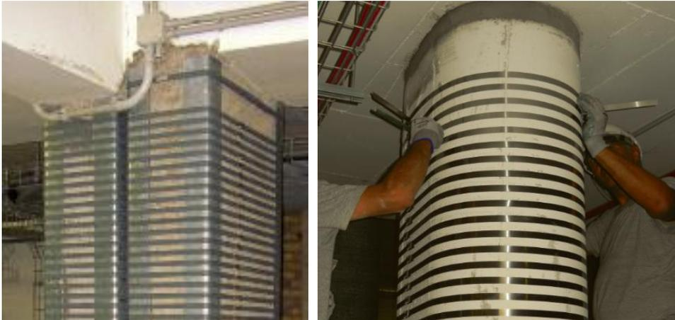
Fig. 17 - Intervento a taglio e confinamento di pilastri
